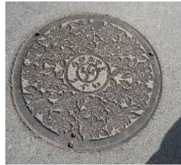
流山市の雨水幹線マンホール
